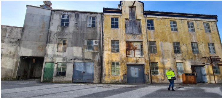
Figur 83, Bygg 18 til venstre og bygg 17 til høgre på bildet. Foto: Nordplan
