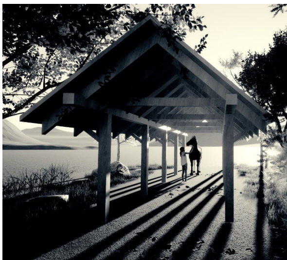
Illustrasjon av skjermende overbygg der gondolbane kryssar ridesti, slik føresegnene opnar for. Høgde må vere slik at hest med rytter kjem gjennom, breidde slik at to hestar kan møtast. (Nordplan)
