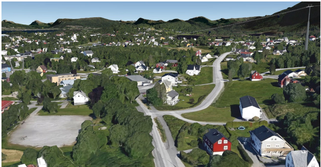
Bana sett frå vest. Molværsvegen midt i bildet, Remane og mast 5 til høgre.
